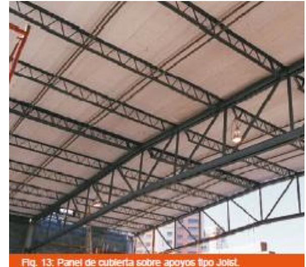
Fig. 13: Panel de cubierta sobre apoyos tipo Jolist.
