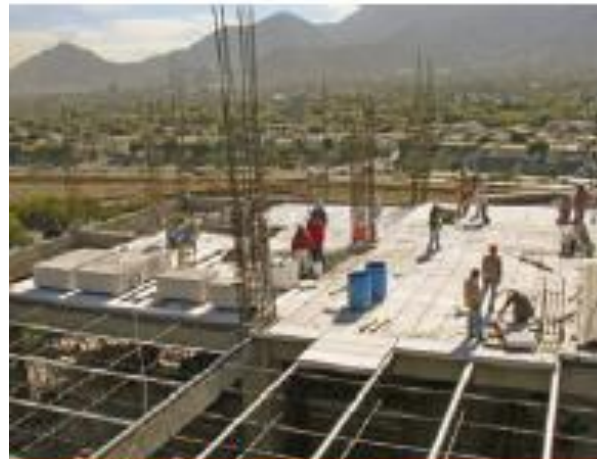
Fig. 10: Revisar la alineación de los paneles y tableros.
