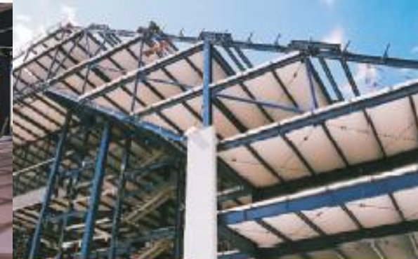
Fig. 27: Vista inferior de panel de entresiso.
