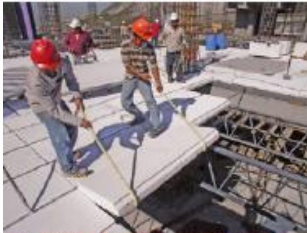
Fig. 9: Volteo del panel con cuerdas (notese la posición del panel para facilitar la instalación).
