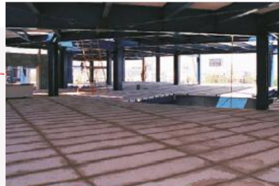
Fig. 25: Juntas entre paneles coladas y afinadas.
