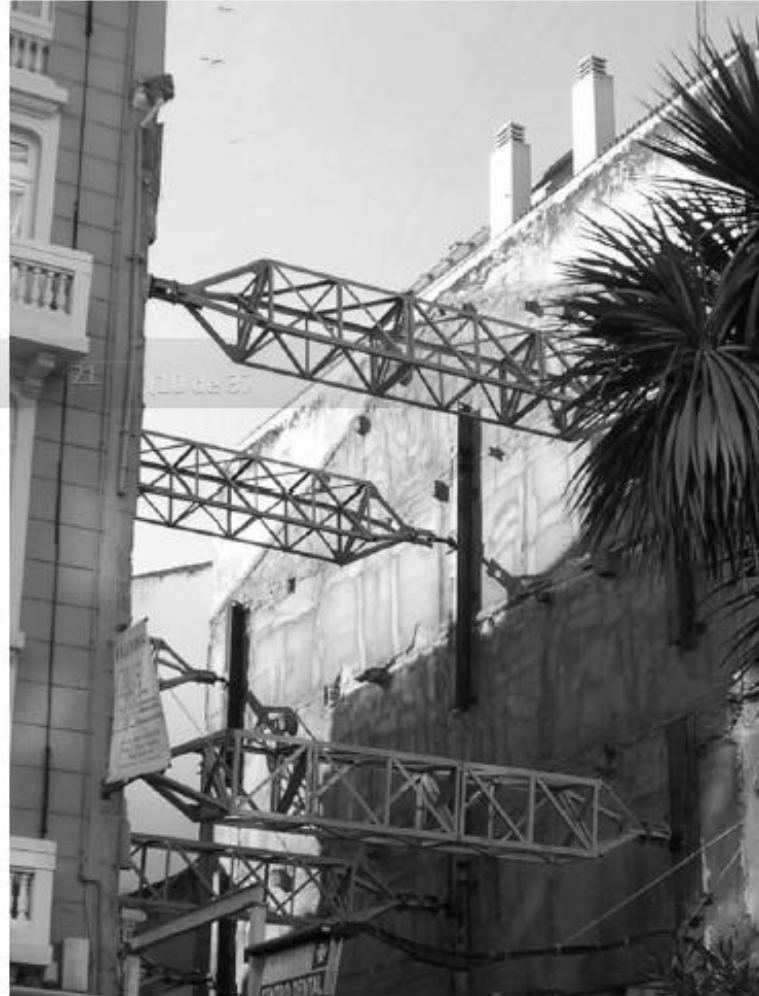
Sistema de acodalamiento con celosías con tornillos de apriete.
