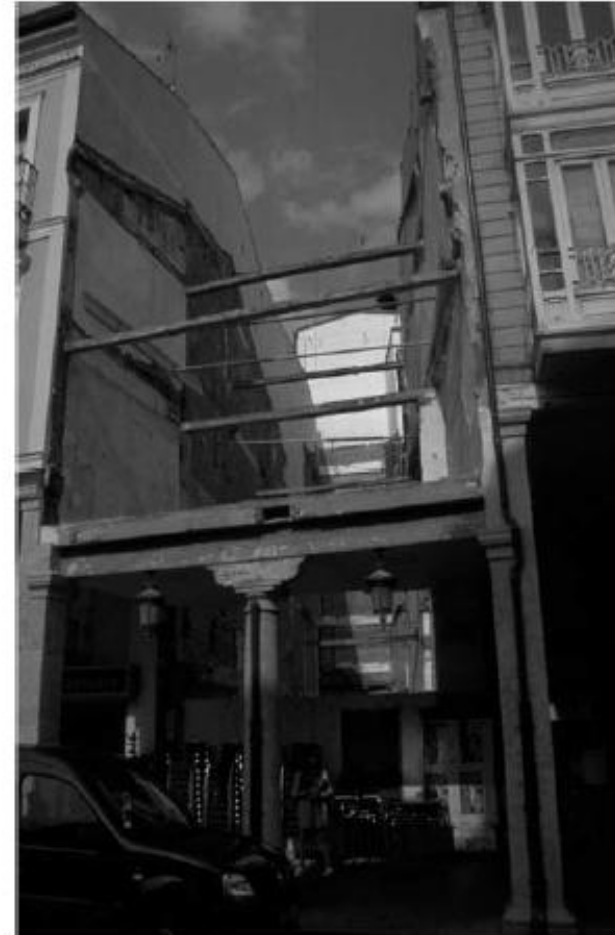
Sistema de acodalamiento manteniendo las vigas. (Muy ineficaz).
