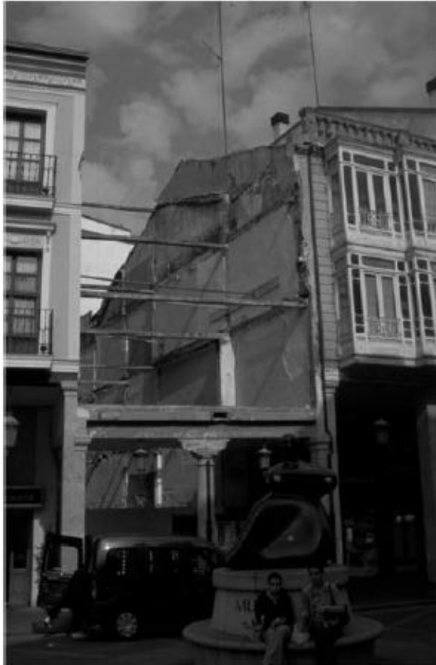
Sistema de acodalamiento manteniendo las vigas. (Muy ineficaz).
