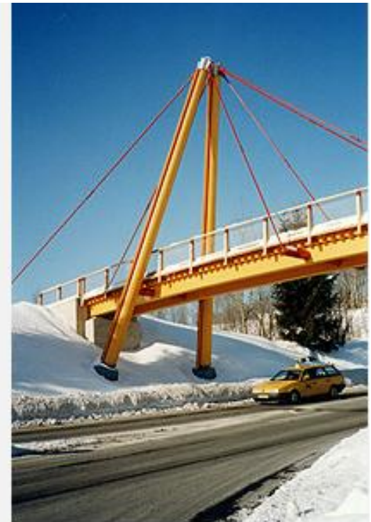
Puente peatonal en Ahornöd
