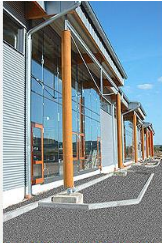
Columnas de madera para fachada de una fábrica de cocina
